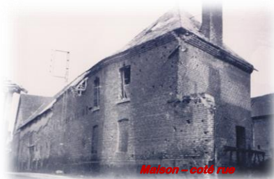
Maison – côté rue
